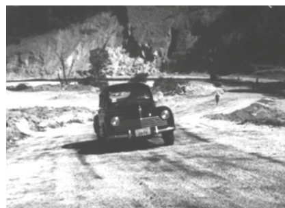
Construção da Rodovia Grajaú-Jacarepaguá
